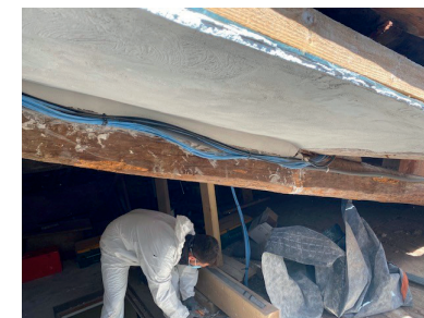
Intérieur de la médiathèque
