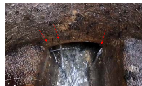
exemple d'infiltration - CAMPING CGU (RV575)
