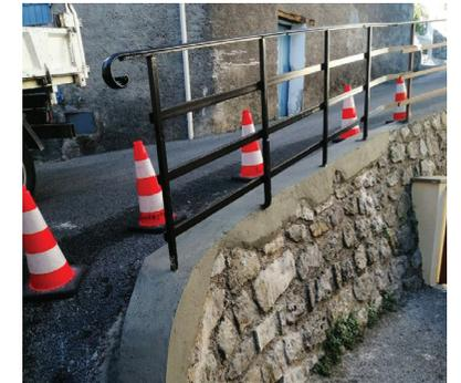
Création et pose d'un garde-corps avec réfection du muret dans le virage de la rue de l'Hubac derrière l'église.
