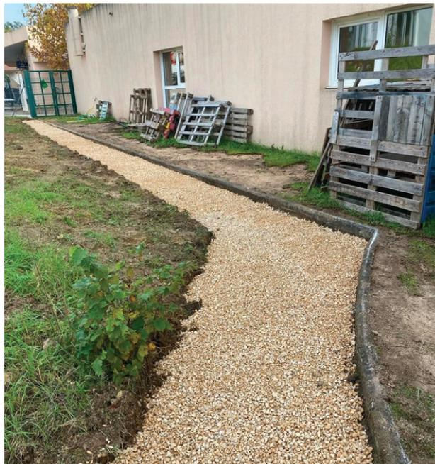
Sécurisation de l'école suite aux fortes précipitations : création d'une nouvelle zone pour éviter que l'eau stagne au niveau de la façade nord et s'infiltrer par le biais du joint de dilatation.
